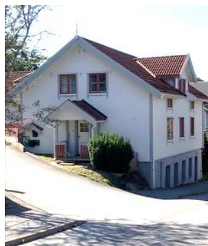
Den gamle kirken slik den ser ut i dag. Den er ombygget til leiligheter.
